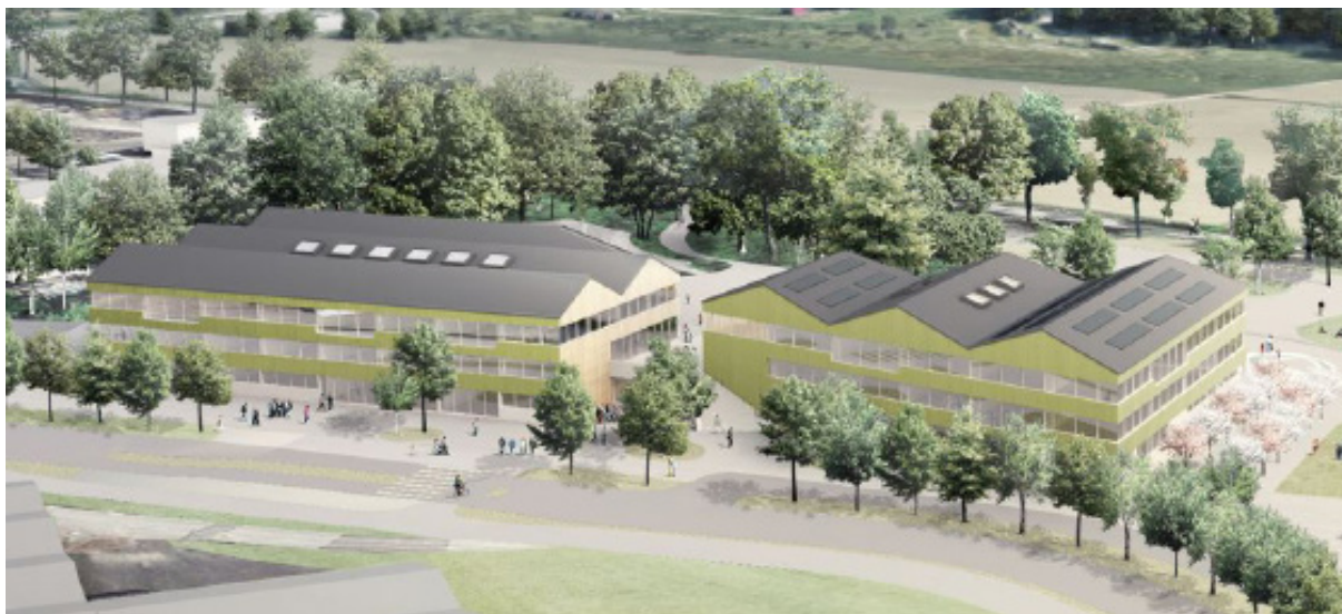
Fig 16. Skolbyggnaden ska delas upp i två volymer och utformas med upprepade sadeltaksmotiv. Volymernas förskjutning formar en entréplats framför byggnaden mot Bryggavägen. (LLP Arkitekter)
