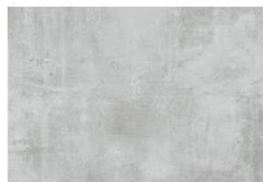
Delar av sockelväning av matrisgjuten betong/betong.
