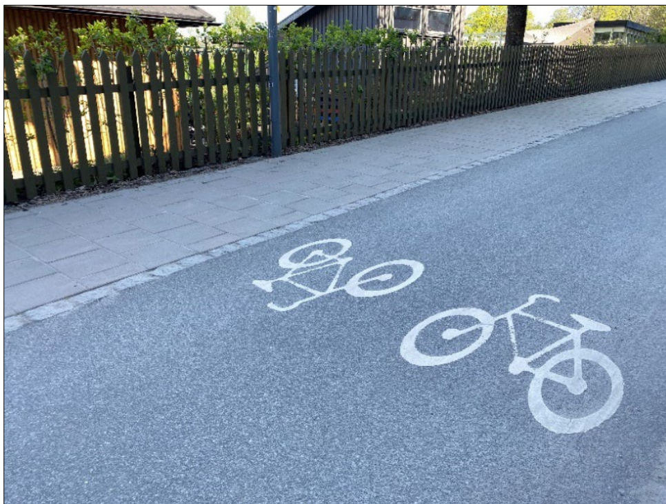
Figur 13. Exempel på hur en separerad dubbelriktad gång- och cykelväg kan utformas med hjälp av varierande markbeläggning. Gångbanan har utformats med plattor och cykelbanan med asfalt. Mellan gång- och cykelbanan följer en skiljelinje i avvikande material i form av en rad med gatsten. Cykelsymbolerna hjälper till att ytterligare tydliggöra separeringen.
